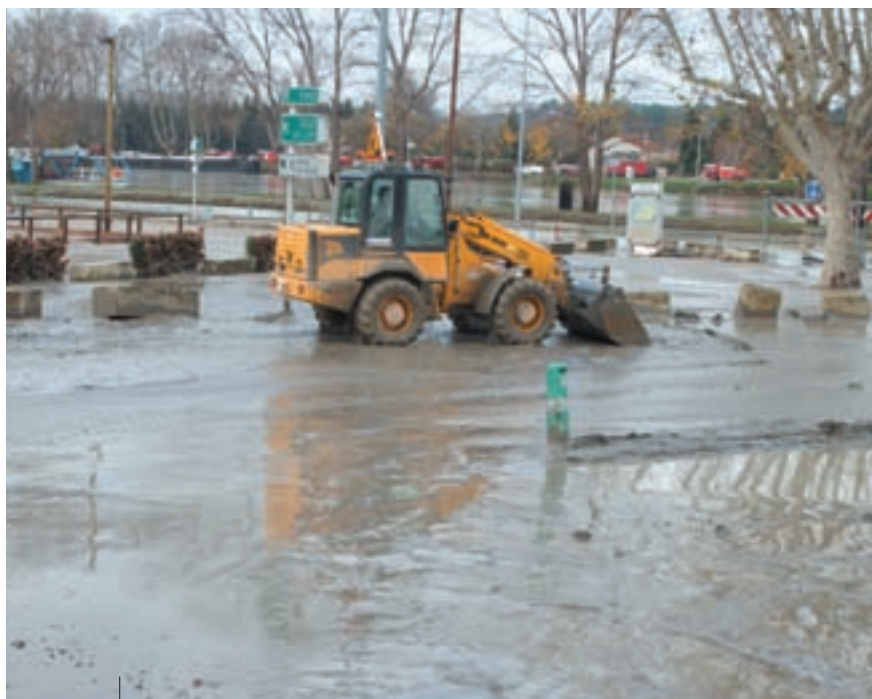
Crue du Rhône - Avignon - nettoyage des quais décembre 2003
